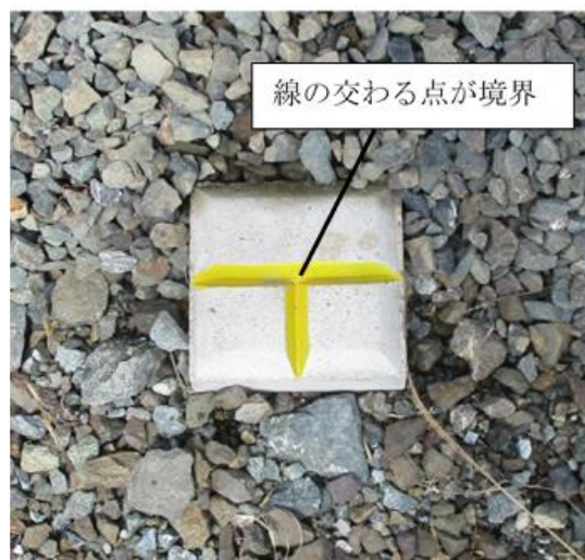
コンクリート杭
